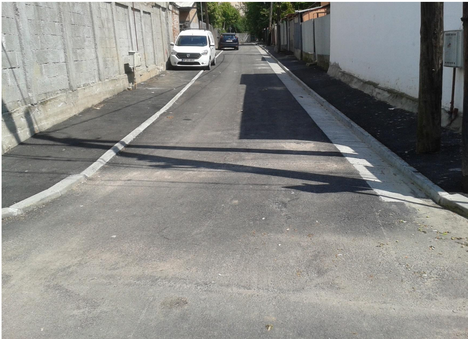
Strada Culmea Făgărașului - finalizată
