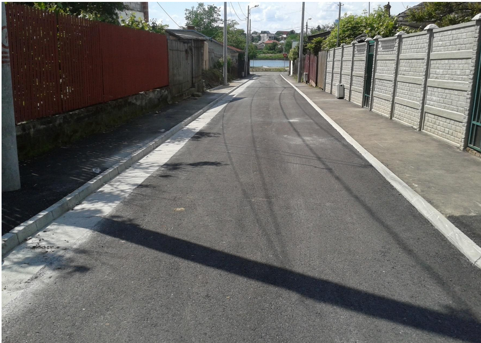
Strada Aristotel - finalizată
