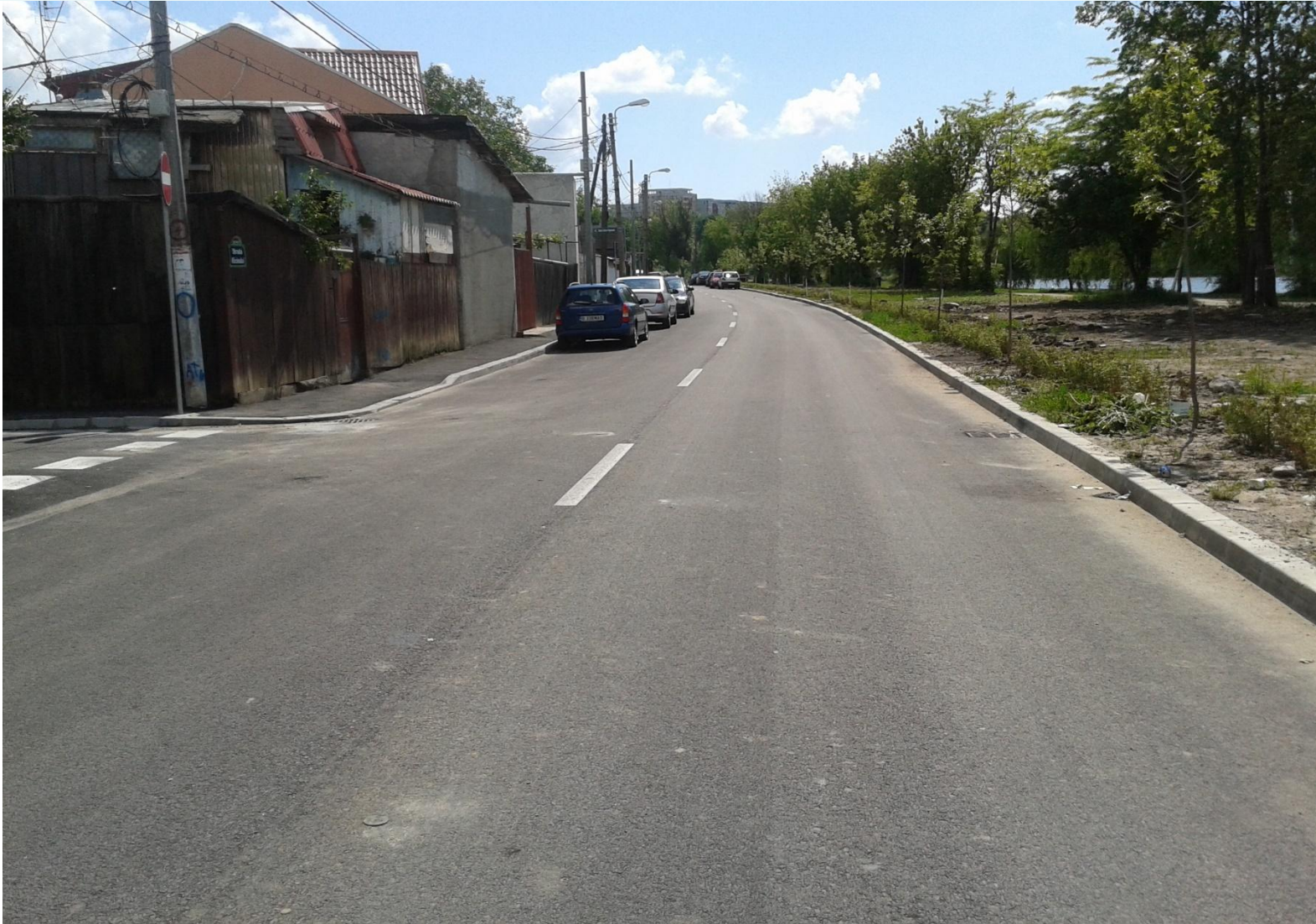
Strada Ricinului - finalizată
